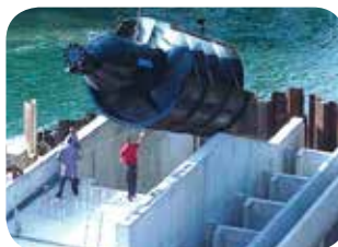
▷ Mise en place de la vis hydrodynamique
