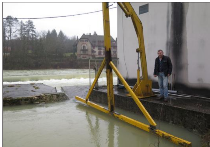
Dans la centrale gérée par Bertrand Olivier à Pont-de-Poitte, l'eau arrive par un canal de dérivation. Les grilles jaunes servent à retenir les débris charriés par l'Ain qui s'écoule sous le bâtiment. L'électricité est produite grâce à une hauteur de chute de 4 mètres. Photo Progrès/Élodie CASTELLI
